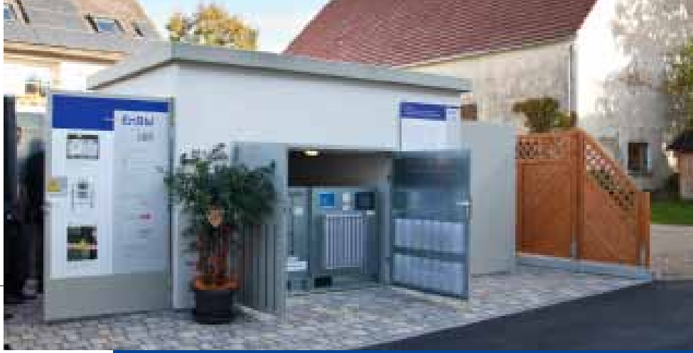
Deutschlands erste intelligente Kompaktstation mit stufenloser Spannungsregelung in Wechingen
