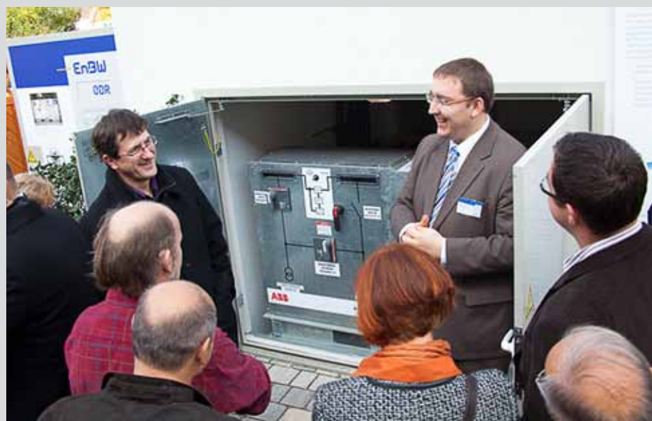
RiesLing, unsere Pilotanlage im Ries - Leittechnik intelligent gemacht. Bau und Inbetriebnahme von Deutschlands erster intelligenter Kompaktstation mit stufenloser Spannungsregelung. Ein Gemeinschaftsprojekt von der EnBW Regional AG, ABB, Deutsche Telekom und EnBW ODR AG.
