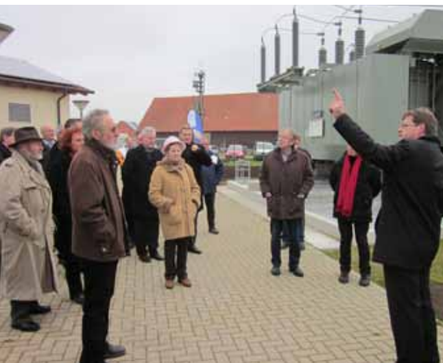
Umspannwerk Crailsheim - Neubau Schaltanlage
