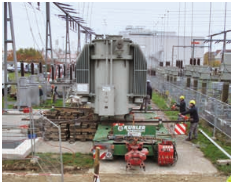
Anlieferung des Umspanners im Umspannwerk Herbrechtingen
