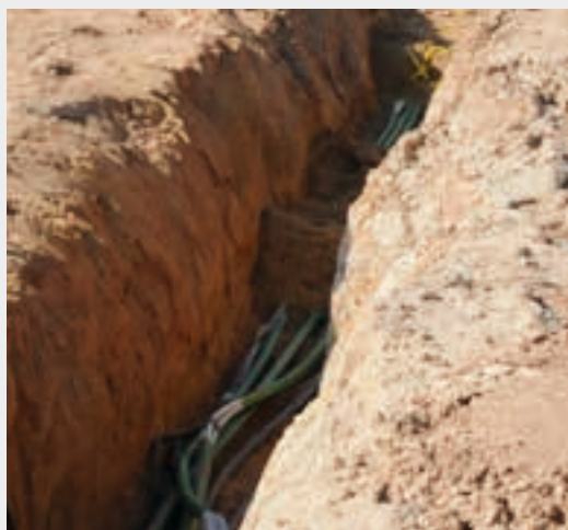
Blick in den Kabelgraben
