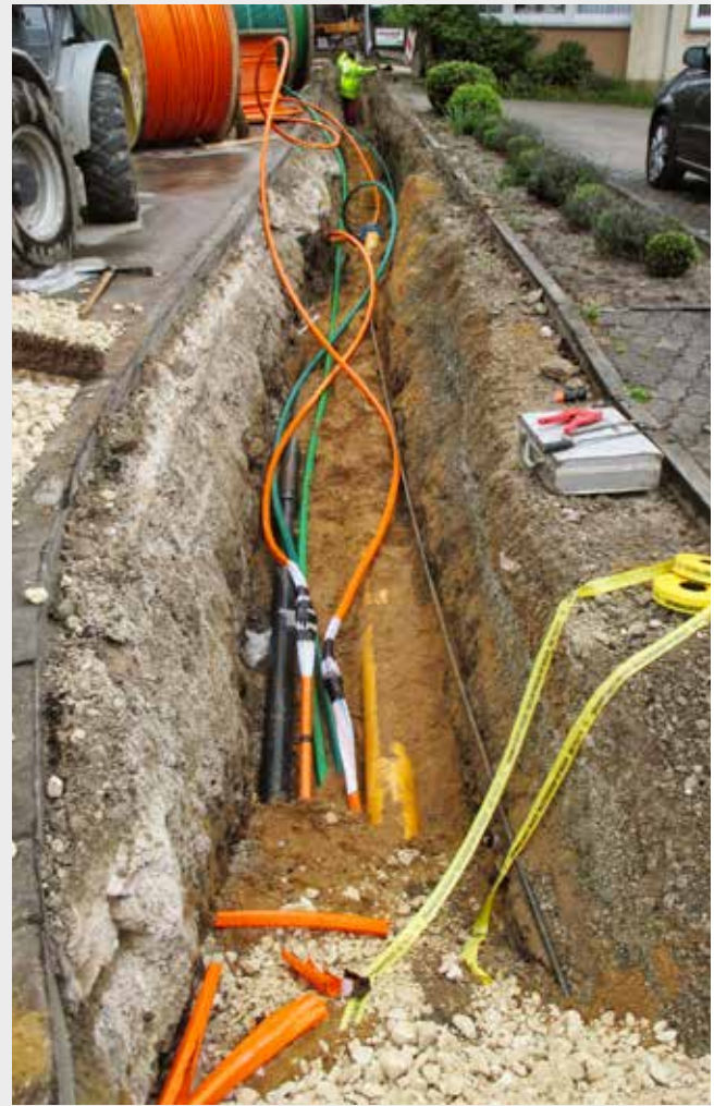
Bild links: HD-Einbindung bei der Gaserschließung in Matzenbach
