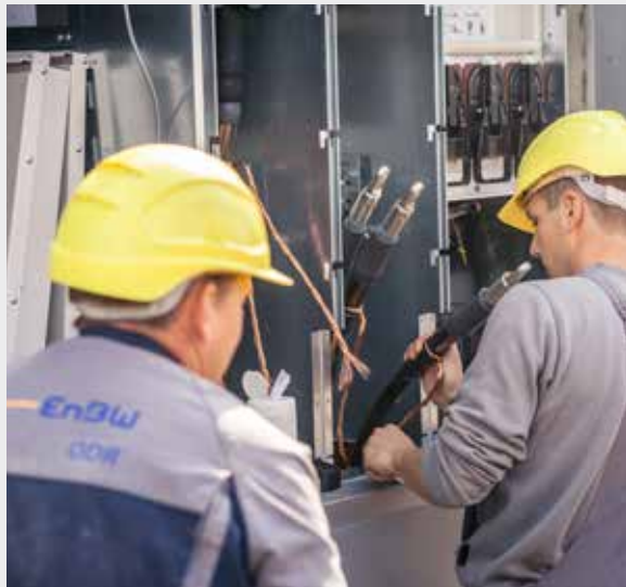
Montagearbeiten an der Trafostation im Neubaugebiet Zeppelinstraße in Neuler
