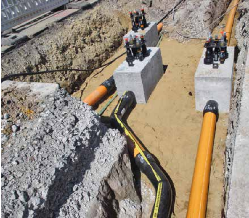
Bild unten: Glasfasererschließung zwischen Wilburgstetten und Höllmühle
