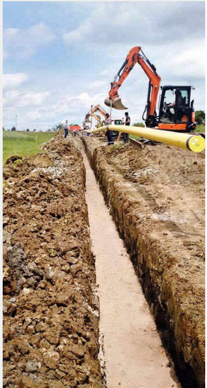
Im Zuge der B29-Ortsumfahrung Möglingen wurde eine Gas-Hochdruckleitung verlegt.
