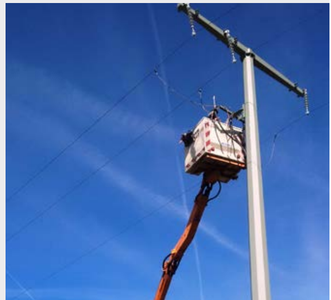
Die Freileitung wurde nach der Verkabelung in Ellenberg-Bernhardsweiler abgebaut.
