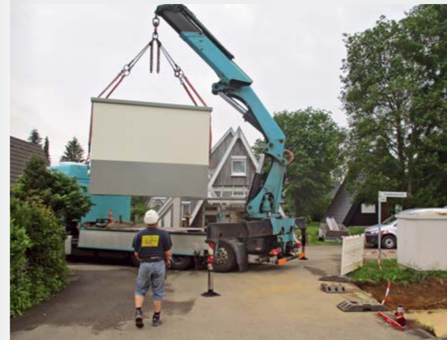
Stationsbau Amalienhof: Norwergerweg Anlieferung und Montage der Umspannstation
