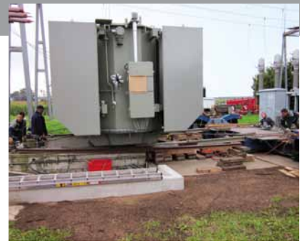
UW Wechingen Umladung des Trafos vom Tieflader auf das Trafofundament
