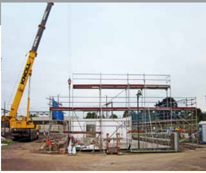
UW Nördlingen Fertigteilmontage
