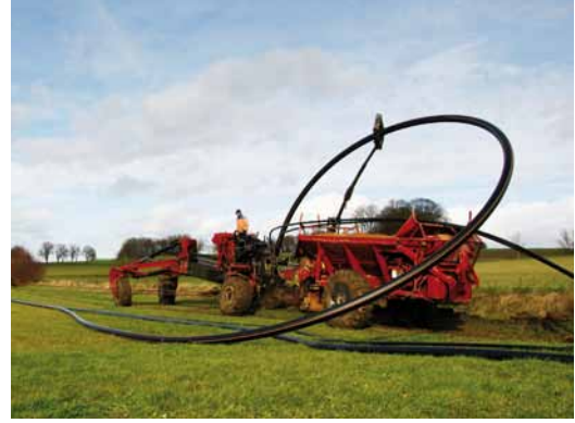
Umweltschonende Pflugverlegung in Wasserschutzzone 2
