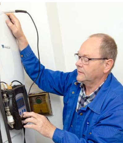
Für die Installation eines neuen Heizkessels brauchen erfahrene Handwerker nur wenige Stunden.
