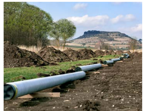
Die neuen Gasleitungen verbinden nicht nur den lpf mit dem Daniel, sondern können auch zukünftig Wasserstoff transportieren.
