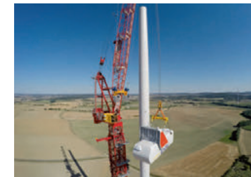
Der Windpark Rot am See in Hohenlohe im Entstehen: Hier drehen sich drei Anlagen des Typs Vestas V 126 mit einer Leistung von je 3,3 Megawatt (MW) und einem Rotordurchmesser von 126 Metern.
