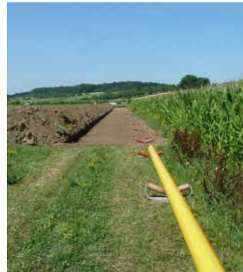
Gas-Hochdruckleitung wartet auf Einzug unter Bahngleis
