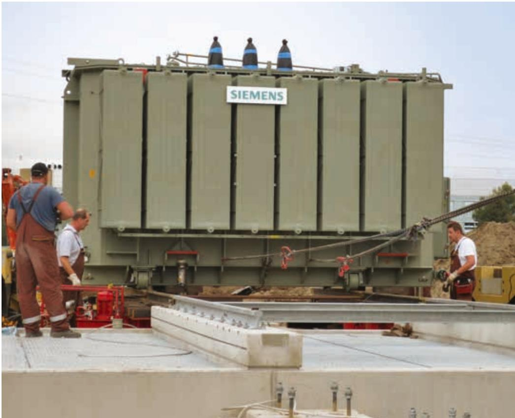
oben: Anlieferung 110 kV-Trafo im Umspannwerk Brenz
