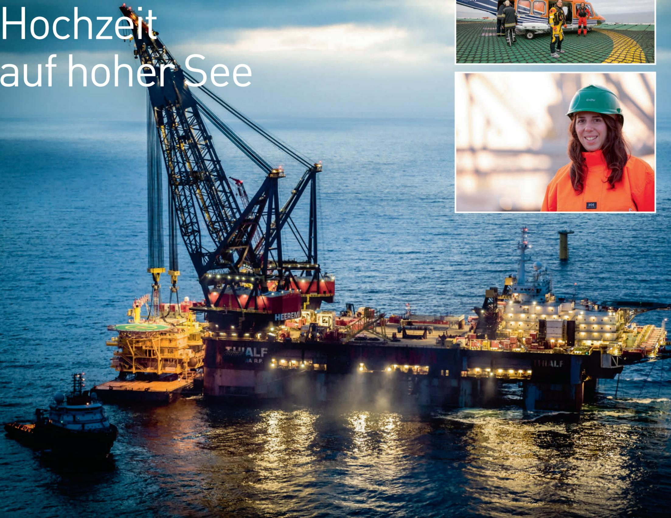
Die Umspannplattform ist das Herz und Hirn des Windparks. Die Kabel aller Windkraftanlagen laufen bei ihr zusammen. Der gebündelte Strom wird dann auf eine höhere Spannungsebene transformiert und später auf einer Plattform des Übertragungsnetzbetreibers in Gleichstrom umgewandelt. Dadurch kann der Strom mit wenigen Verlusten ins Netz an Land eingespeist werden. Außerdem enthält sie die Kommunikations- und Steuerungstechnik für den Windpark.
